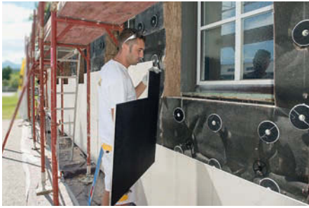
Das Fassadensystem lässt sich problemlos zerlegen und in seine Baustoffe rückführen.
