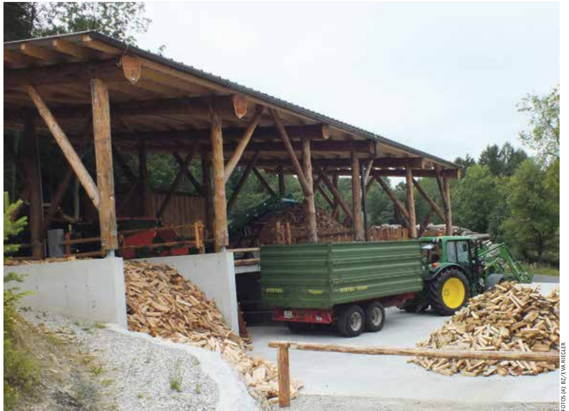
Die neue Halle wurde aus mondphasengeschlägertem Lärchenholz in Rundbauweise errichtet. Neben hoher Funktionalität zeichnet sich das Bauwerk durch perfekte Anpassung an das Landschaftsbild aus.
